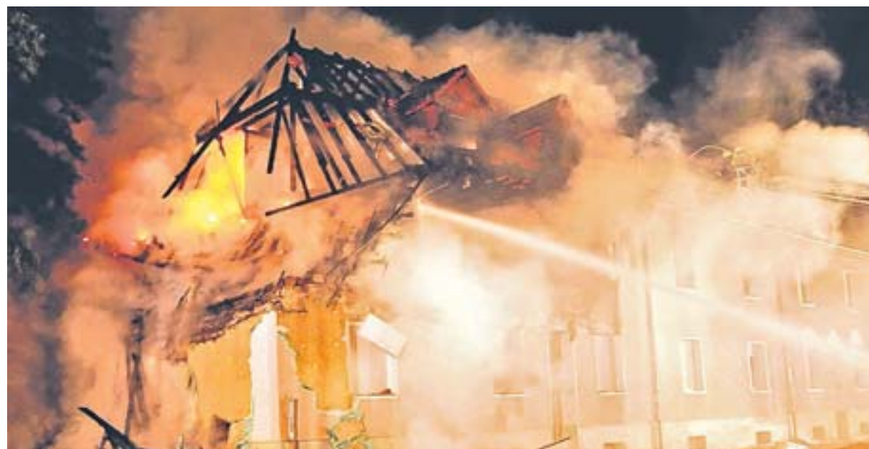
So gewaltig war die Explosion in diesem Wohnhaus in Gladbeck, dass die Vorderfront des Hauses weggesprengt wurde, der Dachstuhl brannte aus. Die Ursachen des Unglücks sind unklar. Eine 61-Jährige starb, ein Mann wird vermisst. FOTO: BLUDAU
